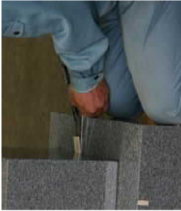
5. 位置決用治具の抜き取り
