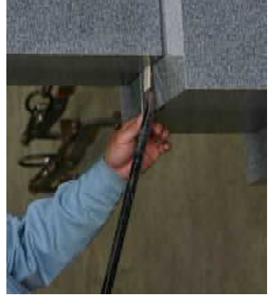
10. 位置決用治具の抜き取り
