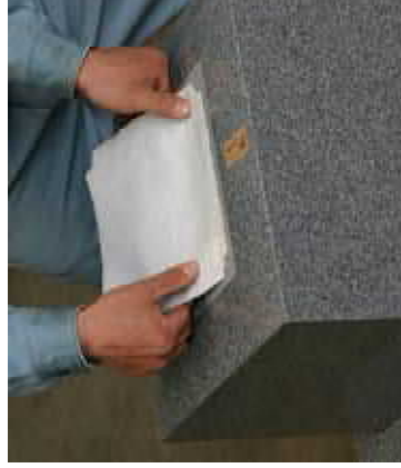
7. 不倒シートの貼付
